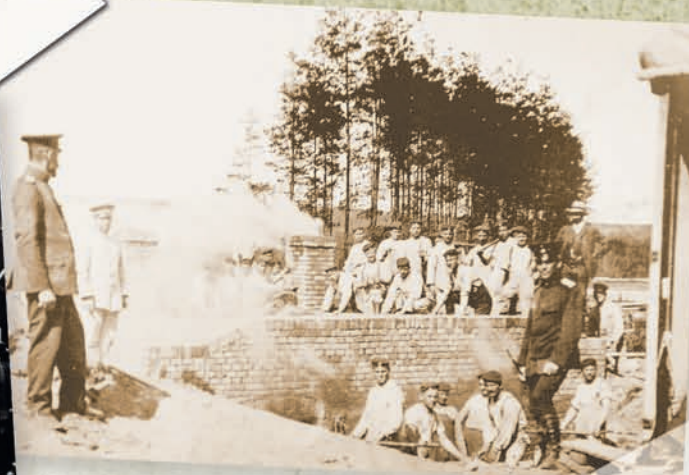
Bauarbeiten in Grafenwöhr – die Aufnahmen zeigen Arbeiter, Ingenieure und Soldaten beim Errichten der Anlage in den Jahren vor dem Ersten Weltkrieg.
